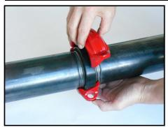
Fare scivolare il giunto aperto sul tubo e sulla guarnizione.
