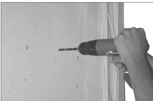
Per prima cosa eseguire i fori al muro per il fissaggio del contenitore della centrale Elisa 24. Realizzare anche il foro per la vite di chiusura del contatto dello switch di tamper.
