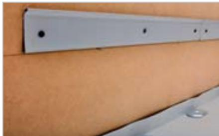
Fissare meccanicamente alla parete il profilo terminale MAPEPLAN PVC-P con tasselli ad espansione o viti a testa svasata, posti ad interasse massimo 25 cm.
