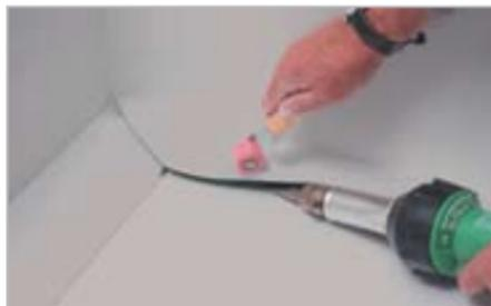
Posizionare il lembo superiore in modo che il bordo abbia inclinazione di circa  $45^\circ$ , arrotondare il bordo con una forbice.
