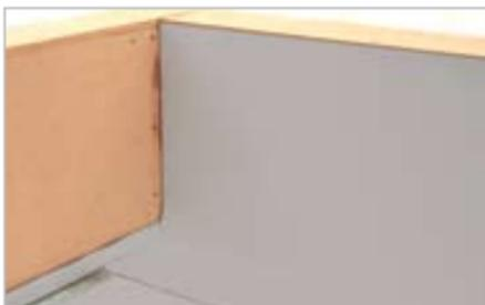
Dopo l'evaporazione dei solventi unire insieme le due superfici da incollare, avendo cura di evitare la formazione di pieghe o bolle sul manto impermeabile.
