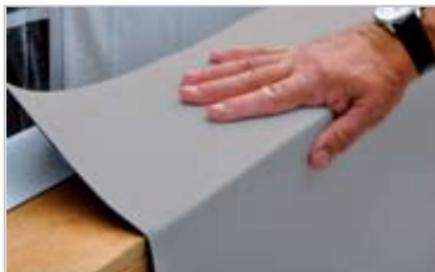
Misurare, segnare e pre-piegare il manto di risvolto in corrispondenza dello spigolo interno, in modo che l'angolo risulti bene aderente al parapetto, come indicato in figura.
