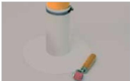
Se non è consentito l'accesso superiore o la dimensione del tubo è particolare, usare un rivestimento prefabbricato di diametro superiore, tagliarlo su un lato e avvolgerlo intorno al tubo e successivamente richiuderlo mediante saldatura ad aria calda. Saldare la flangia al manto di copertura. Altrimenti realizzare questo dettaglio con il manto senza armatura MAPEPLAN D.
