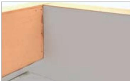
Applicare l'adesivo a contatto MAPEPLAN ADS 200 sul supporto del risvolto verticale e sul manto impermeabile, **avendo cura di non sporcare con l'adesivo le superfici che dovranno essere saldate.**
