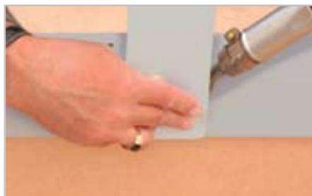
Per garantire che il frontale del profilo rimanga allineato, inserire una striscia di lamiera metallica al di sotto del giunto, assicurandosi di stringerlo nel labbro inferiore del gocciolatoio.
