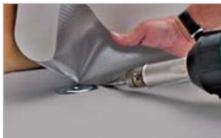
Fissare il profilo di bordo MAPEPLAN T con tasselli ad espansione o viti a testa svasata posti ad interasse massimo 25 cm.
