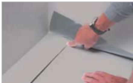
Incollare o fissare meccanicamente il manto sul risvolto verticale. Per facilitare questa operazione può essere utile piegare preventivamente il manto per dargli la forma necessaria, con il saldatore ad aria calda ed il rullino, prima di applicare il risvolto.
