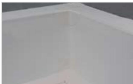
*Saldare ad aria calda il risvolto verticale del manto al frontale verticale del profilo di bordo.*
