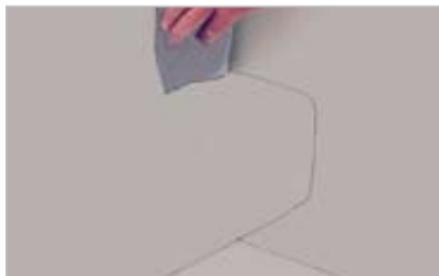
Tagliare, arrotondare ed applicare il risvolto adiacente come precedentemente descritto. Sui manti di spessore 1,5 mm e superiore, è necessario rimuovere/ smussare il gradino lungo il bordo del sormonto dove i manti vengono saldati tra loro. Questa lavorazione previene ogni rischio di capillarità attraverso il sormonto. Questa procedura si realizza utilizzando uno specifico raschietto smussatore (per esempio attrezzo Dremel) come indicato nella figura.
