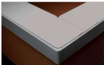
Per facilitare la saldatura del manto di ricopertura al profilo di bordo, lasciare 1 cm di distanza tra il manto e lo spigolo esterno del profilo. Realizzare la puntatura, la pre-saldatura e la saldatura finale ad aria calda.
