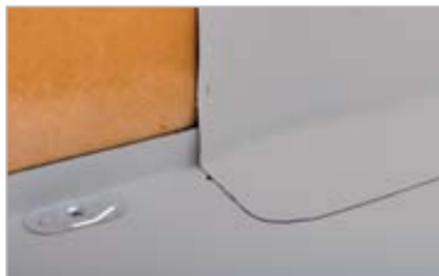
Puntare e saldare il risvolto verticale del manto impermeabile alla base del parapetto. Completare con la pre-saldatura e la saldatura finale del risvolto al manto di copertura.
