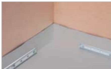
Fissare meccanicamente la parte terminale del manto MAPEPLAN PVC-P di copertura con profili preforati o piastrine. Il manto deve essere fissato alla base del risvolto, sulla superficie orizzontale o verticale.
