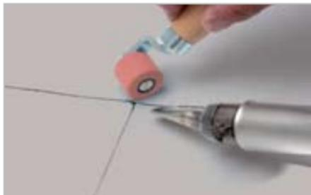
I giunti trasversali o “giunti a T” si formano quando i sormonti dei manti si sovrappongono per più di una volta. Sui manti di spessore 1,5 mm e superiore, è necessario rimuovere/smussare il gradino lungo il bordo del sormonto dove i manti vengono saldati tra loro. Questa lavorazione previene ogni rischio di capillarità attraverso il sormonto.
