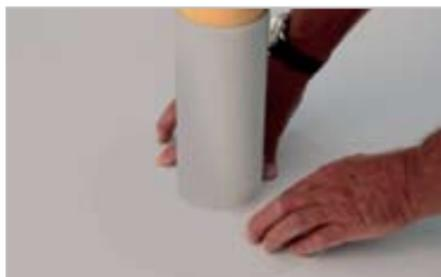
Tagliare un foro nel manto di copertura ed infilare il manto sul tubo come indicato in figura.
