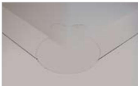
Posizionare l'angolo esterno prefabbricato. Iniziando dal centro dell'angolo verso l'esterno realizzare la puntatura e la pre-saldatura, prima di completare con la saldatura finale.
