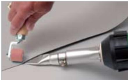
Posizionare l'ugello inclinato di 45° rispetto alla linea di saldatura.
