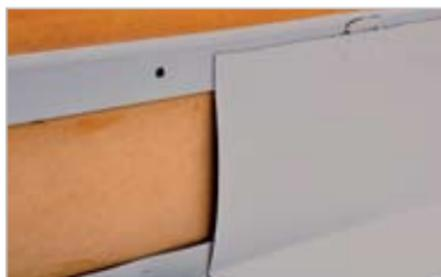
Completare con la pre-saldatura e la saldatura finale del risvolto verticale al profilo terminale.
