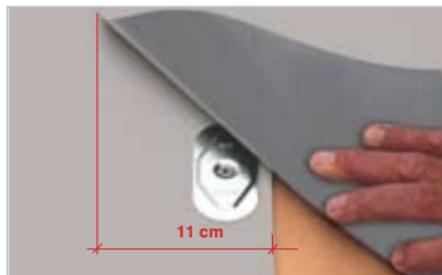
Prima di procedere alla saldatura assicurarsi che i sormonti siano puliti ed asciutti. (Fare riferimento a pag. 9 procedura di pulizia e preparazione dei sormonti).
