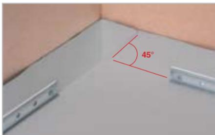
Nel sistema di fissaggio meccanico i manti MAPEPLAN T M/Mf devono essere fissati meccanicamente lungo tutti i perimetri e le aperture con barre preforate o piastrine metalliche. Il manto deve essere fissato alla base dei risvolti, sulla superficie orizzontale o verticale.
