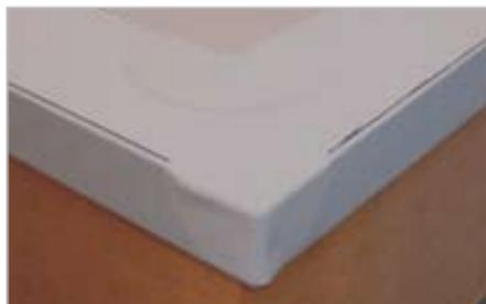
Completare il dettaglio con la saldatura sulla faccia esterna di un angolo pre-fabbricato interno come indicato in figura.
