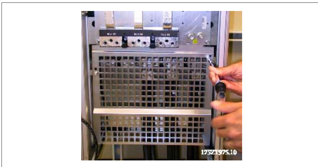
Disegno 3.81: Montaggio della schermatura EMC.
