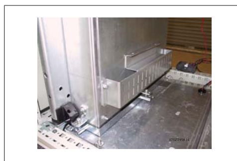
Disegno 3.59: Condotto inferiore installato.
