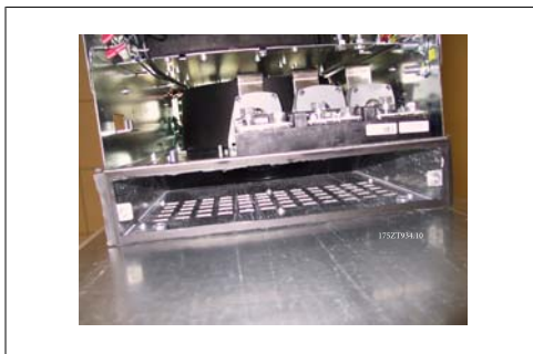
Disegno 3.33: Adattatore del condotto inferiore installato
