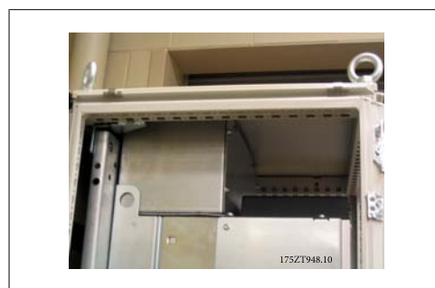
Disegno 3.49: Parte superiore della custodia installata
