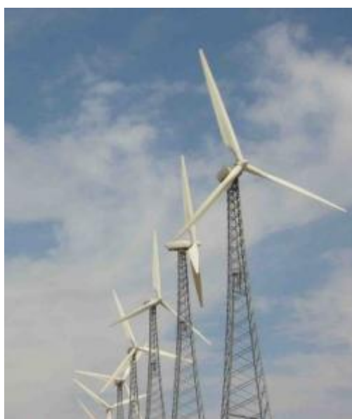
72. Rotori eolici con torre in traliccio.
