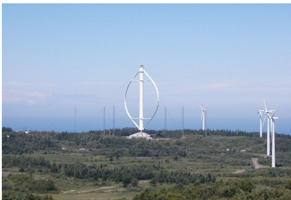
53. Turbina Darrieus da 4MW nel parco eolico di Gaspé Peninsula, Quebec, Canada.
