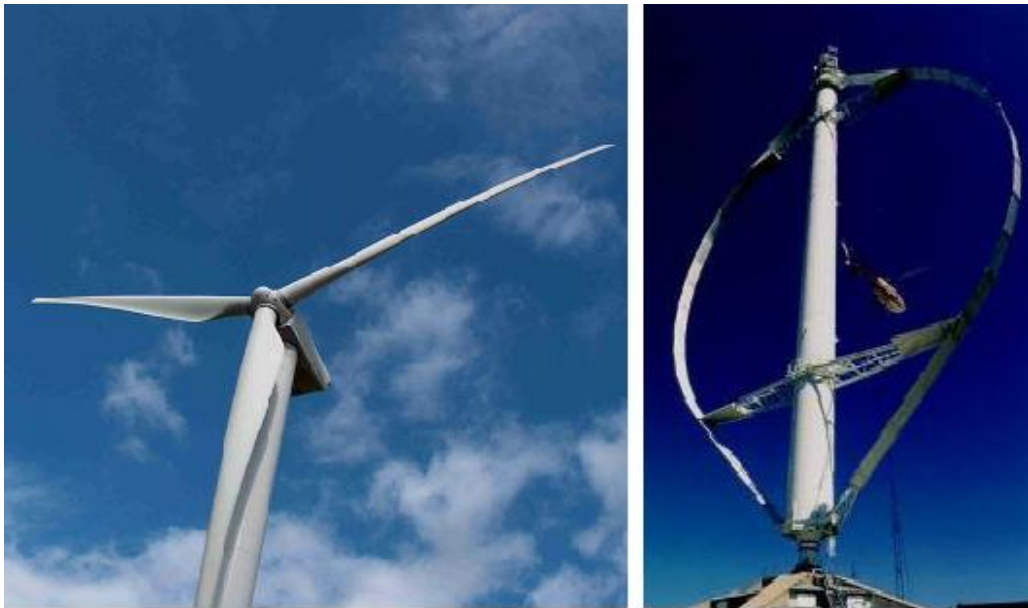
43. Esempi di turbine eoliche a portanza.
