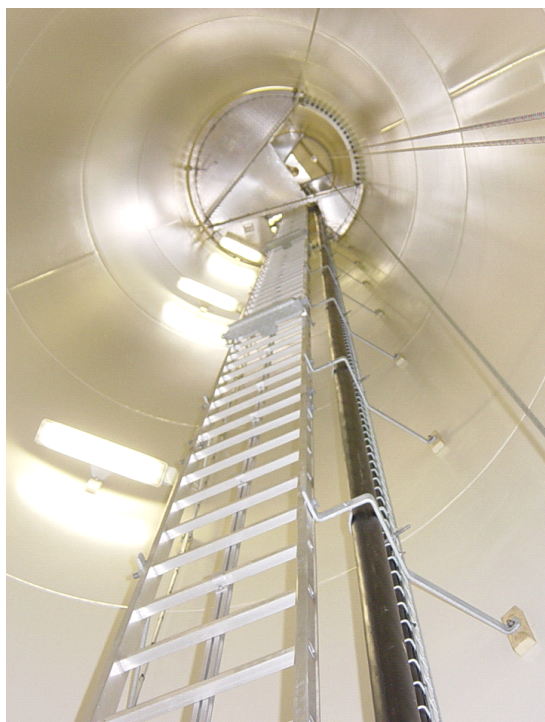
74. Vista interna di una torre tubolare.
