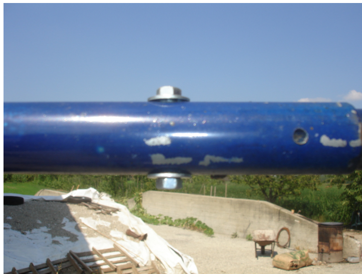
117. Collegamento tra i bracci A ed i bracci B.
