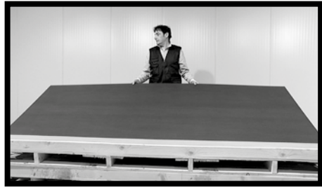
Fig. 1 - Une personne suffit pour manutentionner les dalles 300x100 cm de KERLITE de différentes typologies. Soulever lentement la dalle, les mains ouvertes, par le côté long de manière à éliminer l'effet ventouse dû à l'adhérence avec la dalle située au-dessous et à permettre une bonne préhension.
