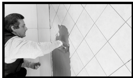
Fig.61 - Posa a parete
