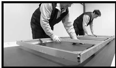
Fig.4/5 - Les différents types de dalles de KERLITE en format 300x100 cm peuvent être manutentionnées par deux personnes à l'aide d'un châssis spécial. Fixer le châssis à la dalle lorsque celle-ci est encore dans la palette. Soulever ensuite le châssis et la dalle de manière à éliminer l'effet ventouse.
