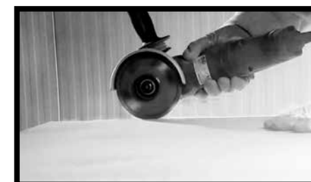
Fig. 21 - Les mêmes résultats s'obtiennent avec des disques de ponçage appliqués sur une ponceuse à main.
