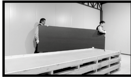
Fig.3 - Lorsque la dalle est en position verticale, la soulever en la prenant par le bord supérieur, puis, avec l'aide d'une deuxième personne, la déplacer en la tenant toujours droite.
