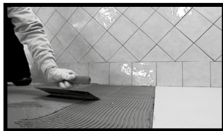
Fig.62 - Posa a pavimento
