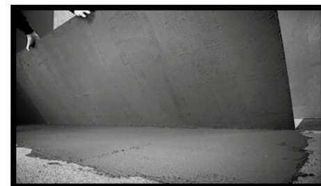
Fig.68 - 2 - Vanno posate appoggiando uno dei lati lunghi e quindi accompagnandole a terra.
