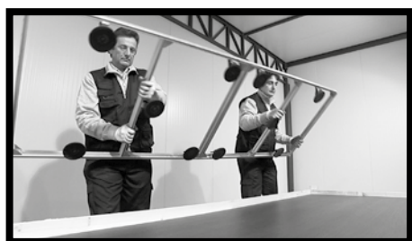
Abb.4/5 - Die verschiedenen Typen der Platten KERLITE im Format 300x100 cm können mit Hilfe eines dazu dienenden Rahmens von zwei Personen befördert werden. Dazu den Rahmen an der noch auf der Palette befindlichen Platte befestigen. Dann Rahmen und Platte zur Überwindung des Saugeffekts anheben.
