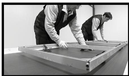
Abb.4/5 - Die verschiedenen Typen der Platten KERLITE im Format 300x100 cm können mit Hilfe eines dazu dienenden Rahmens von zwei Personen befördert werden. Dazu den Rahmen an der noch auf der Palette befindlichen Platte befestigen. Dann Rahmen und Platte zur Überwindung des Saugeffekts anheben.
