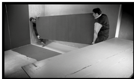
Fig.67 - 1 - Vanno movimentate portandole prima in posizione verticale sostenendole per il bordo superiore, quindi muoversi mantenendole sempre rettilinee con l'aiuto di una seconda persona.
