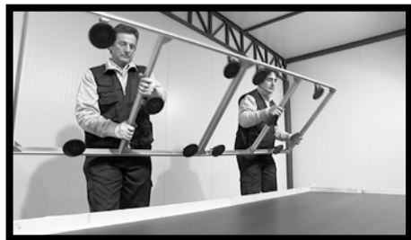
Fig.4/5 - Les différents types de dalles de KERLITE en format 300x100 cm peuvent être manutentionnées par deux personnes à l'aide d'un châssis spécial. Fixer le châssis à la dalle lorsque celle-ci est encore dans la palette. Soulever ensuite le châssis et la dalle de manière à éliminer l'effet ventouse.
