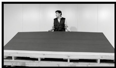
Abb.1 - Zum Heben der Platten 300x100 cm aller KERLITE-Typen genügt eine Person. Die Platte mit offenen Händen langsam an der langen Seite abheben, um den Saug-effekt durch die Haftung an der darunter befindlichen Platte zu überwinden und ein sicheres Ergreifen zu ermöglichen.
