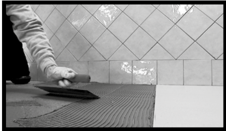
Fig. 62 - Pose au sol
