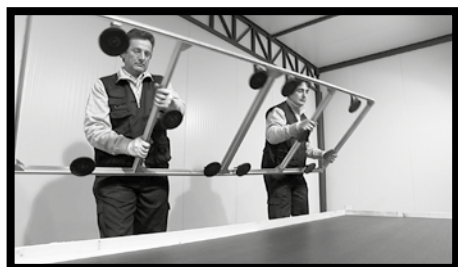
Fig.4/5 - Le lastre di KERLITE nelle sue varie tipologie nel formato 300x100 cm possono essere movimentate da due persone con l'ausilio di un apposito telaio. Fissare il telaio alla lastra quando è ancora all'interno del pallet. Quindi sollevare il telaio e la lastra per eliminare l'effetto ventosa.
