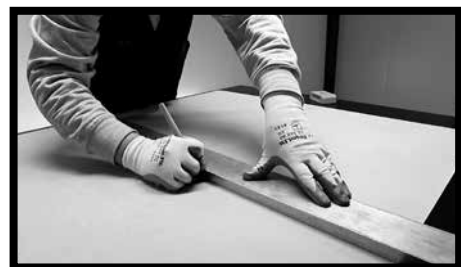
Fig.10 - Pour couper le plus droit possible, on peut s'aider d'une truelle en aluminium de maçon.
