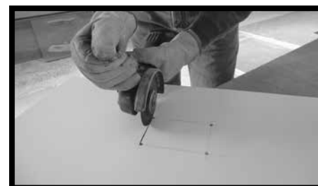
Fig. 19 - Pour la réalisation de découpes internes et de découpes en « L », il est conseillé d'arrondir les sommets de l'ouverture avec des mèches de 5 mm au moins afin de diminuer le risque de rupture. Découper au moyen de scies diamantées en ayant soin de ne pas interrompre l'avancement après avoir atteint le trou précédemment réalisé. Pour l'exécution de trous et de découpes au moyen de scies diamantées, suivre les indications fournies précédemment.
