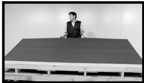
Fig.1 - Le lastre 300x100 cm di KERLITE, nelle varie tipologie, possono essere sollevate da una persona. Alzare la lastra a mani aperte e sollevare lentamente il lato lungo in modo da eliminare l'effetto ventosa dovuto all'aderenza con la lastra sottostante e consentire una buona presa.
