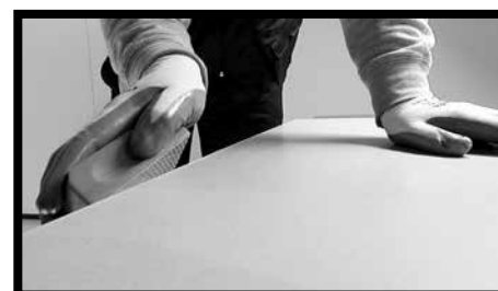
Fig.20 - Les finitions des bords peuvent être exécutées manuellement au moyen d'éponges diamantées ou de papier émeri. Passer légèrement sur le côté de la dalle pour arrondir partiellement ou bien effectuer plusieurs passages pour un effet biseauté.
