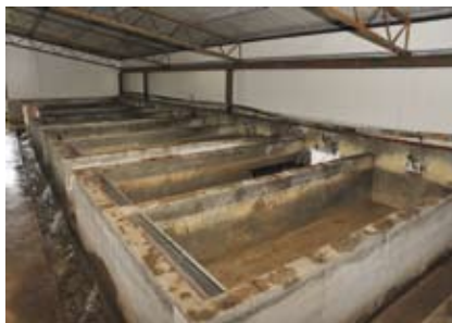
fig. 15 – Vasche in cemento impiegate per lo svezzamento e il pre-ingrasso delle trote.
