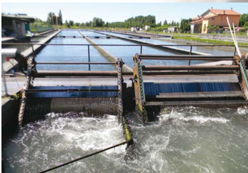
fig. 13 – Troticoltura con sgrigliatore che utilizza acque superficiali.
