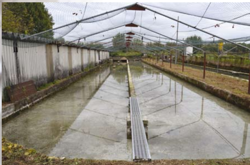
fig. 16 – vasca esterna in cemento a ridotta profondità che può essere utilizzata per l'allevamento dello scazzone.
