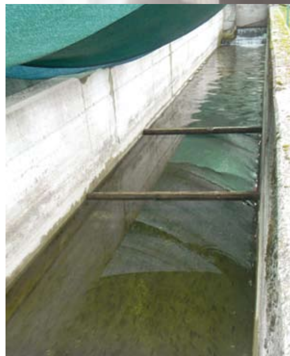
fig. 14 – Vasca tipo raceways con assi di legno per aumentare la velocità al suo interno.
