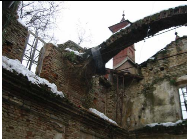
Per limitare le proiezioni si applicano protezioni in rete metallica e strisce di gomma ...
