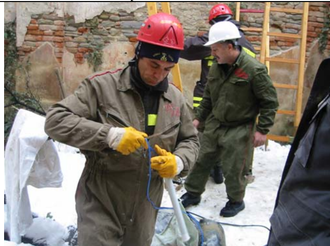
Ormai sicuri i lavori procedono in serie
