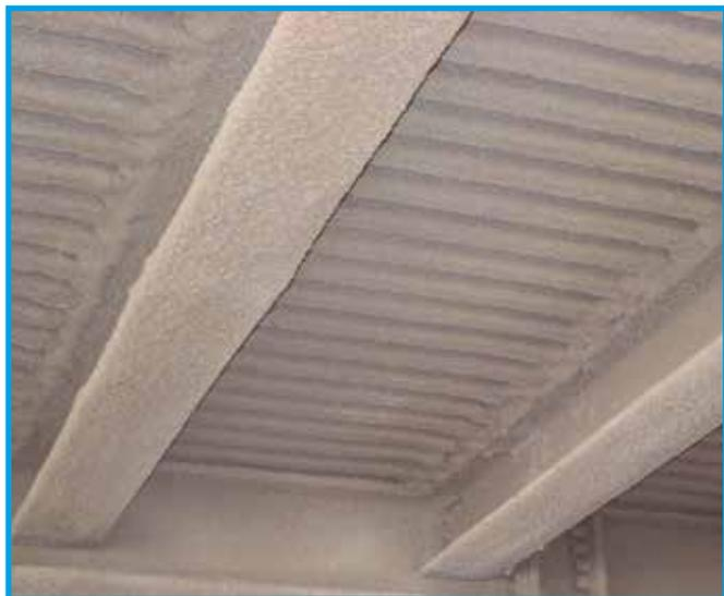
PROMASPRAY® C450 è un intonaco premiscelato leggero a base cemento per la protezione al fuoco di elementi in acciaio e calcestruzzo, qualificato secondo EN 13381. Contributo alla resistenza al fuoco da 15 a 240 minuti a seconda della tipologia di struttura. Si applica mediante spruzzatura uniforme sulle superfici da proteggere, ottenendo un rivestimento di buona qualità, senza giunti né fessurazioni. Si presenta sotto forma di miscela leggera, di colore beige.
