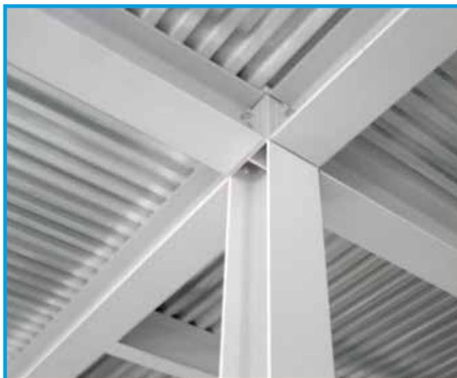
Pittura intumescente monocomponente in emulsione acquosa a base di resine sintetiche per la protezione al fuoco di elementi posti all'interno di edifici in acciaio, calcestruzzo, muratura e legno, qualificata secondo EN 13381. Contributo alla resistenza al fuoco da 15 a 180 minuti a seconda della tipologia di struttura. Nome commerciale: PROMAPAIN<sup>®</sup> SC1 - PROMAPAIN<sup>®</sup> WIP
