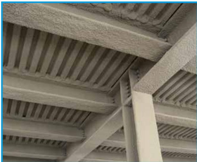
PROMASPRAY® P300 è un intonaco premiscelato leggero a base gesso per la protezione al fuoco di elementi in acciaio, calcestruzzo, lamiera grecata e legno, qualificato secondo EN 13381. Contributo alla resistenza al fuoco da 15 a 240 minuti a seconda della tipologia di struttura. Si applica mediante spruzzatura uniforme sulle superfici da proteggere, ottenendo un rivestimento di buona qualità, senza giunti né fessurazioni. Si presenta sotto forma di miscela leggera, di colore grigio chiaro.
