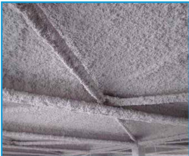
PROMASPRAY® F250 è un intonaco premiscelato leggero applicato a spruzzo qualificato secondo EN 13381 che permette di ottenere una o più delle seguenti funzioni: protezione al fuoco, isolamento termico, correzione acustica e controllo della condensa. Contributo alla resistenza al fuoco da 15 a 240 minuti a seconda della tipologia di struttura.
