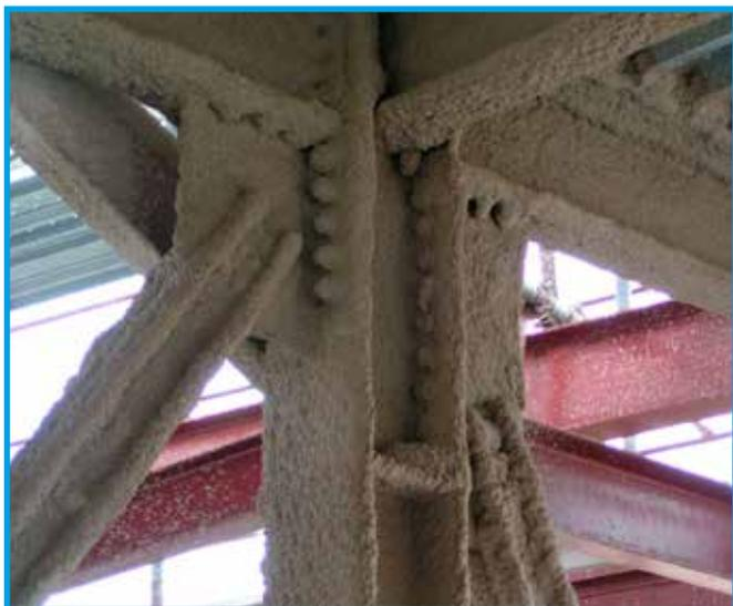
NEWSPRAY® è un intonaco premiscelato leggero per la protezione al fuoco di elementi in acciaio posti all'interno, qualificato secondo EN 13381. Contributo alla resistenza al fuoco da 15 a 240 minuti a seconda della tipologia di struttura. Si applica mediante spruzzatura uniforme sulle superfici da proteggere, ottenendo un rivestimento di buona qualità, senza giunti né fessurazioni. Si presenta sotto forma di miscela leggera, di colore beige chiaro.
