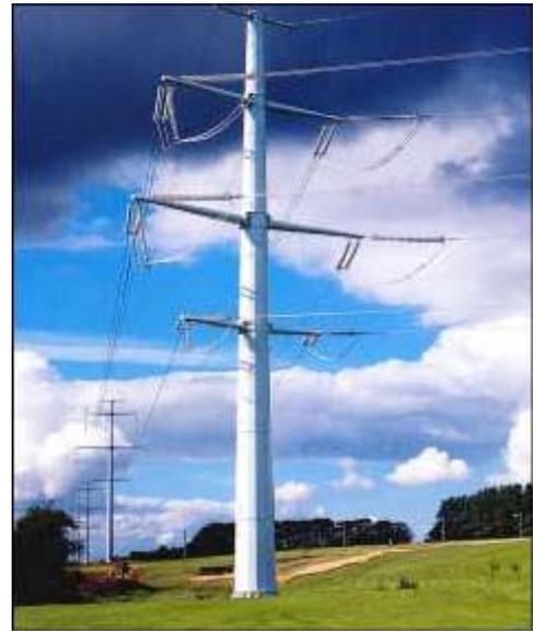
Figura 4a e 4b – Tipologia di sostegni: tubolare monostelo.
