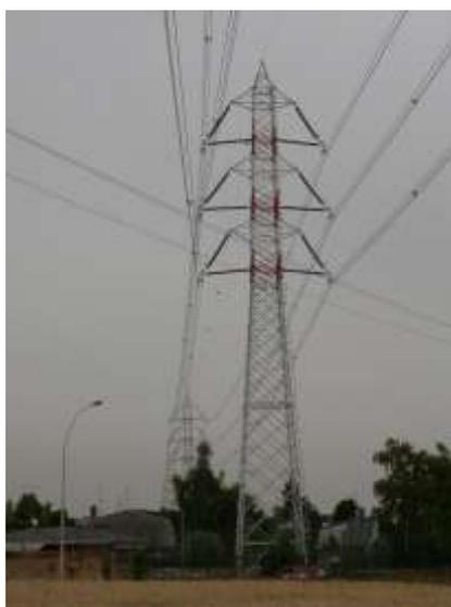
*Figura 3 - Tipologia di sostegni: traliccio a mensole isolanti.*
