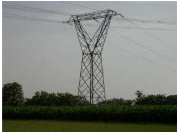
Figure 2a e 2b – Tipologia di sostegni: tradizionale, a tronco piramidale e a delta rovesciato.
