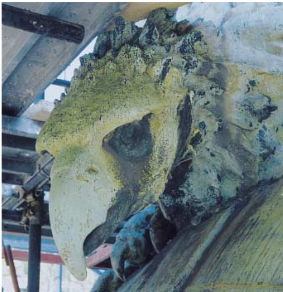
MONUMENTO A VITTORIO EMANUELE II, LE OPERAZIONI DI LAVAGGIO DEL BRONZO:
