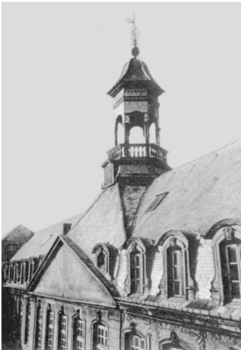
FIG. G. – LE CAMPANILE DU DIJONVAL, CÔTÉ RUE: AU-DESSUS DU FRONTON CLASSIQUE, LA GIROUETTE ET LA CLOCHE D'APPEL OU ..... D'ALARME ; DE PART ET D'AUTRE, LES 12 FENÊTRES DE L'IMMENSE GRENIER BIEN AÉRÉ OÙ LES LAINES ÉTAIENT ENTREPOSÉES AU SEC, ET OÙ LES DRAPS ÉTAIENT SOUVENT MIS À SÉCHER, CHAQUE FOIS QUE LE TEMPS NE PERMETTAIT PAS DE LE FAIRE SUR LES REMPARTS DE LA VILLE OU SUR LES RAMES, AU BORD DE LA MEUSE. PHOTO HENRI MANCEAU PRISE VERS 1960.
