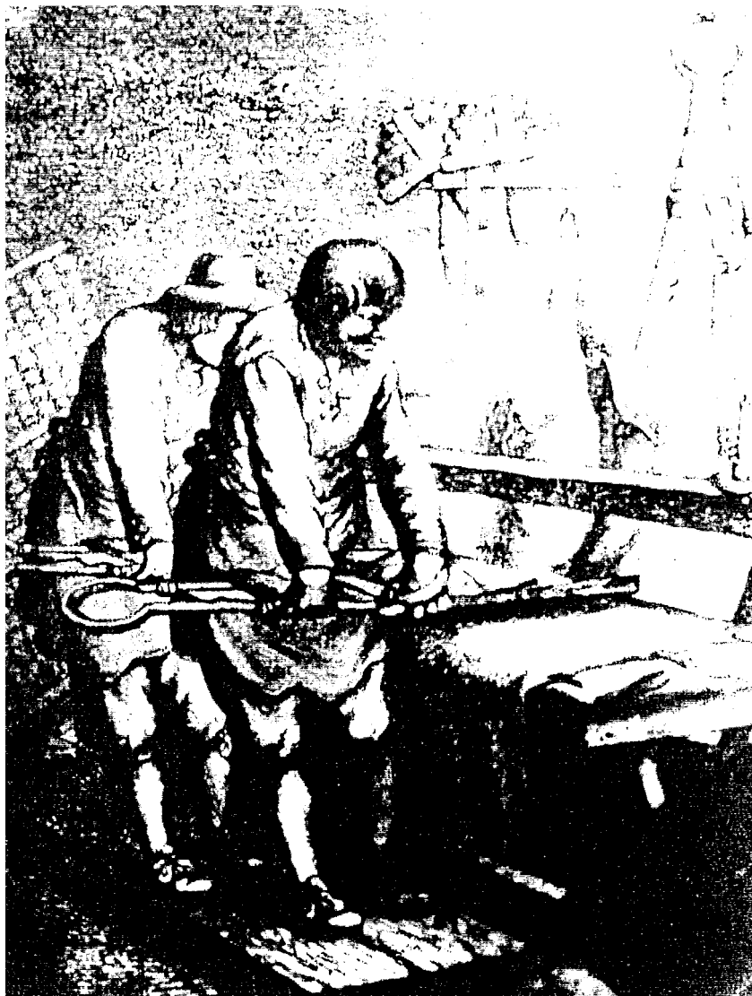
FIG. D. – LES TONDEURS D'AIX-LA-CHAPELLE, COMME CEUX DE SEDAN, ONT LONGTEMPS IMPOSÉ LE TRAVAIL AU CUROT PLUS PÉNIBLE MAIS PLUS PRÉCIS QUE LA MAILLOCHE, DÉGOÛTANT AINSI DU MÉTIER LES ASPIRANTS. CAR C'EST BIEN À LA FORCE DU POIGNET GAUCHE, AUTOUR DUQUEL ET PASSÉ UNE BRIDE DE CUIR, QUE LE TONDEUR ENTRAÎNE LE MOUVEMENT DES LAMES, SANS L'AIDE D'UN LEVIER. POIGNET FORT DÉFORMÉ, SIGNE D'HABILETÉ ET DE PRODUCTIVITÉ.
