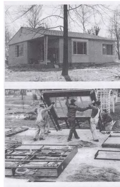
Fig. 3: Una casa prefabbricata modello Lustrom nelle fasi di costruzione 1949
