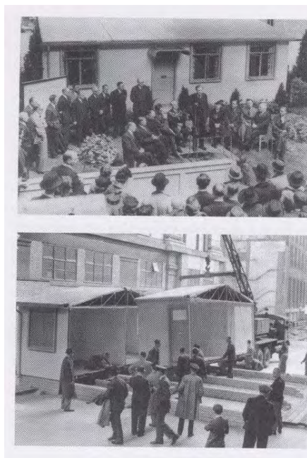
Fig. 4: AIROH casa prefabbricata dimostrativa e fasi di assemblaggio
