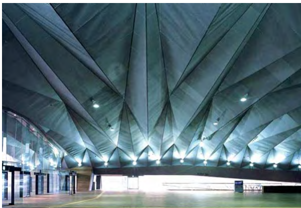
Fig. 19 vista interna della copertura del parcheggio del terminal di Yokohama in Giappone
