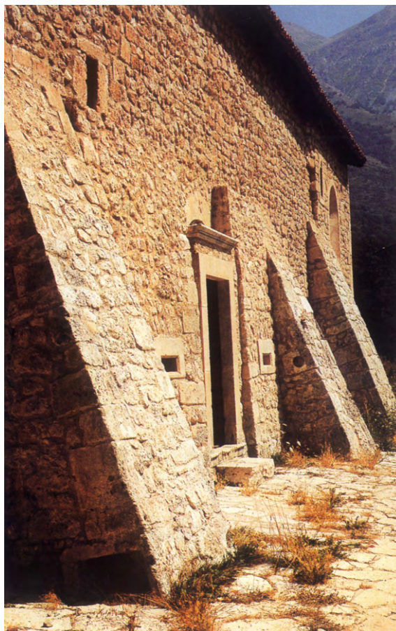
Fig.9-10: La chiesa di Sana Maria in Valle di Roscio. Le maestranze specializzate impiegate nei cantieri ricchi, rappresentano un veicolo di informazioni anche per il cantiere dell'edilizia di base.
