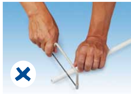
Fig. 17 Non utilizzare seghetti per tagliare il tubo Hep 2 O.
