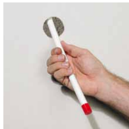
Fig. 30 Proteggere sempre le estremità del tubo.
