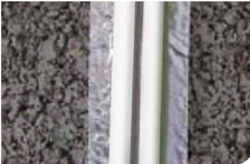
Fig. 49 Il nastro metallico può essere utilizzato per facilitare il rilevamento elettronico del tubo.
