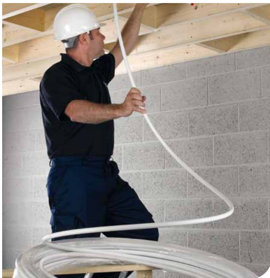
Fig. 31 Conservare il tubo nell'imballaggio fino all'ultimo metro.
