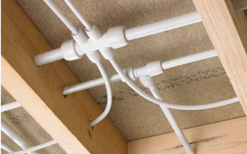
Fig. 48 L'installazione è più rapida e più facile grazie alla flessibilità del sistema Hep 2 O.
