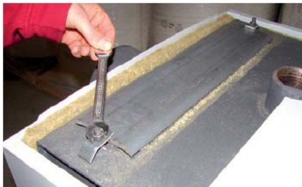
Allentare le viti del coperchio dei tubi scambiatori (chiave piana da 13)
