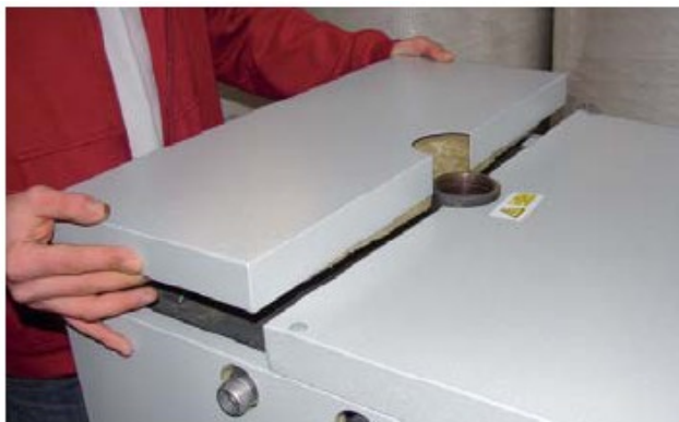
Smontaggio dell'involucro superiore della caldaia (non sono necessari attrezzi)
