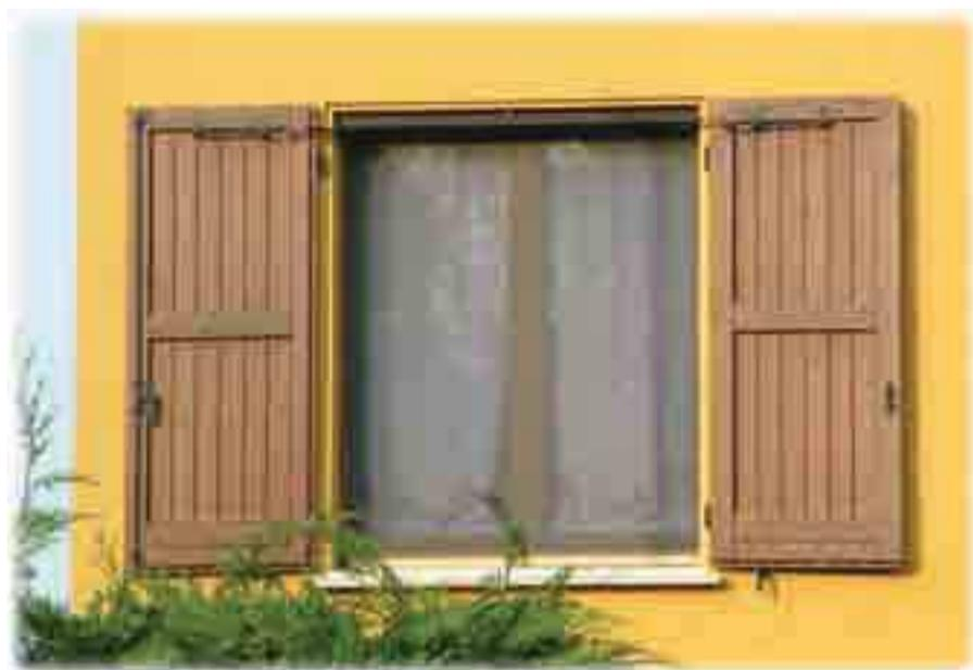
SERRATORE S/A installato sotto architrave in una classica persiana montata a filo muro esterno
