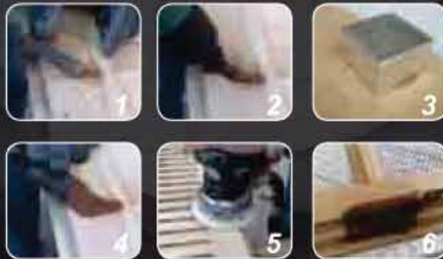
EFG Knot Filler è una resina poliammidica in stick brevettata per la riparazione di fori (anche passanti), fessure, crepe e danni, su superfici piane e su angoli, utilizzabile su ogni tipo di legno. È l'unica resina che contiene Thermelt®, un componente brevettato e registrato che rende questo prodotto unico soprattutto come capacità elastica e flessibilità.
