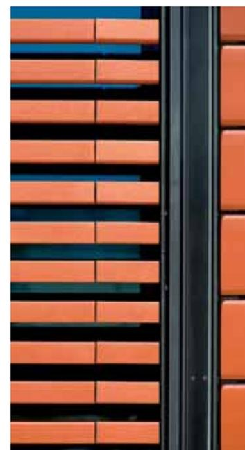
mento all'esterno prevede l'uso di lastre in "terracotta" di grande formato, posate a secco su struttura metallica integrata al pacchetto isolante, con l'ausilio di speciali dispositivi di chiusura laterale e angolare, con parte della struttura portata sulla superficie del manufatto a creare un disegno geometrico.
