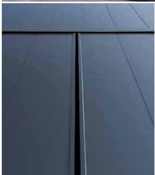
Dettaglio accoppiamento laterale pannelli e fuga dilatazione
