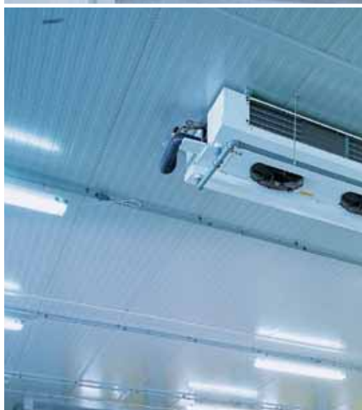
Dettaglio lato interno di una cella frigorifera
