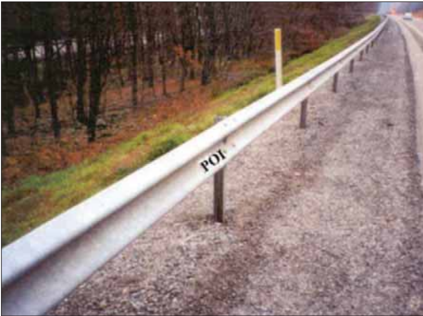
Foto 1 - Guard rail sul margine sud delle corsie dirette ad ovest. Il guard rail è contrassegnato POI (Point Of Impact) per indicare il punto apparente dove ebbe luogo l'impatto con la vittima.
