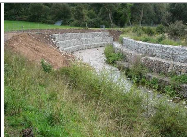
Fig. 5.9 - Opere di protezione spondale e di arginatura lungo il Riu Puddina (Bortigjadas, OT) - Foto G. Tilocca.
