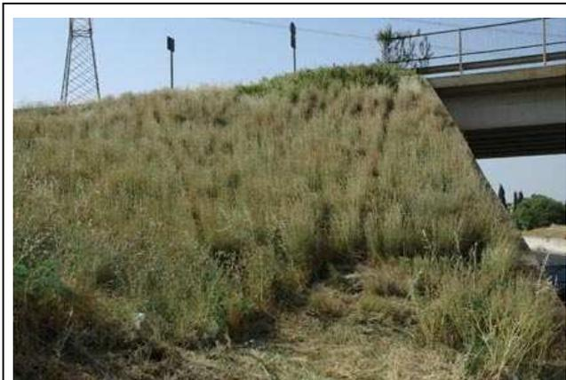
Fig. 6.3 - Sistemazione della scarpata di un rilevato stradale con piantagione di *Hyparrhenia hirta* (S.S. 131, bivio di Sestu) – Foto M. Casti
