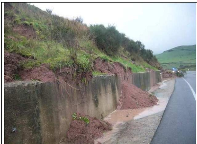
Fig. 5.12 - Colamenti (soil slips) su piroclastiti bentonizzate del Miocene inferiore, km 6,0 S.S. 672 Ploaghe – Perfugas (SS) – Foto G. Tilocca
