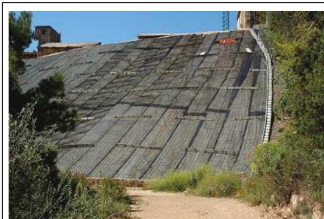
*Fig. 5.1 - Interventi di messa in sicurezza realizzati a Monteponi (Iglesias, CI) – Foto M. Casti*
