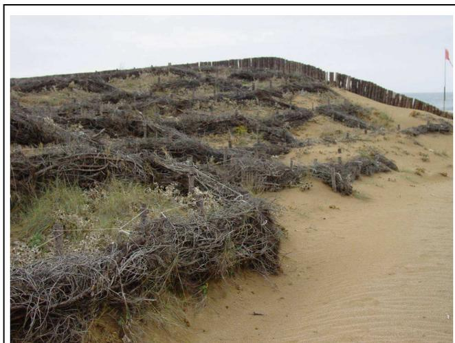
*Fig. 5.2 - Sistema retrodunare della spiaggia di Is Arenas interessato da interventi di stabilizzazione mediante schermi a scacchiera – Foto CriteriA*
