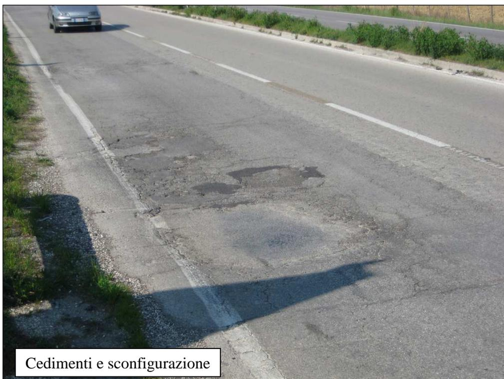
Foto degli ammaloramenti rilevati
