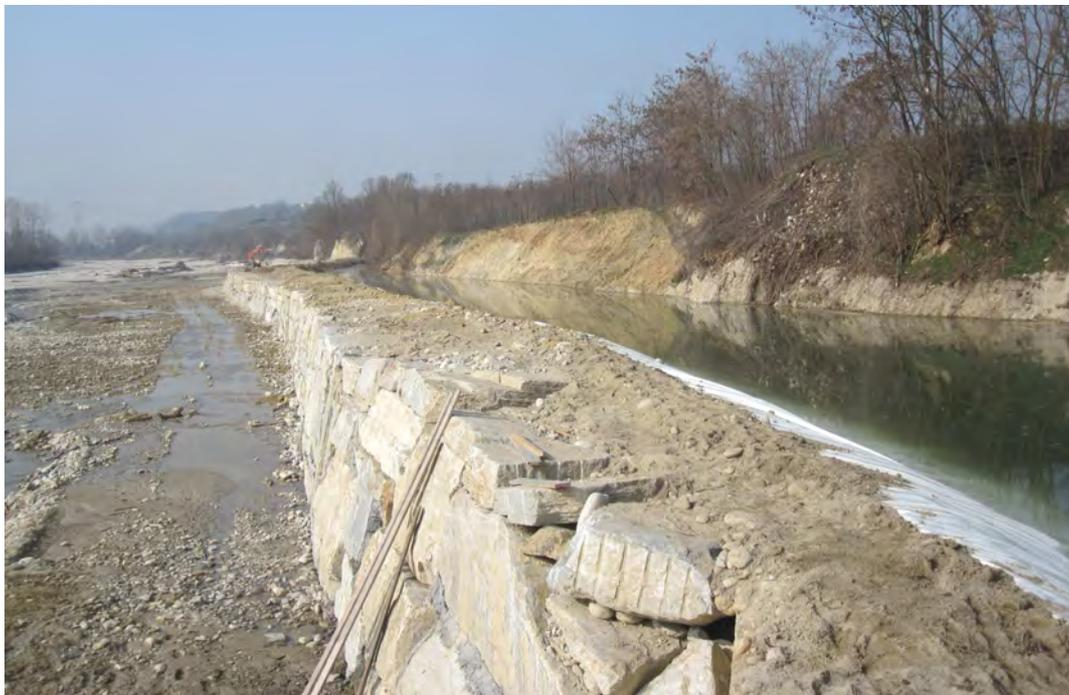
Il canale è esistente fino ad una camera di pompaggio, da dove l'acqua andrà ad irrigare i prati circostanti. A valle di tale manufatto verrà pertanto realizzato un canale ex-novo sino a raggiungere il sito di ubicazione del fabbricato della centrale. La restituzione delle acque avverrà a quota 266,89 m s.l.m., a monte del ponte autostradale.
