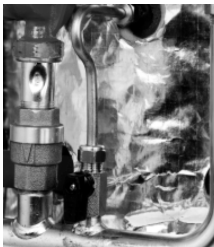
Foto A: rubinetto di caricamento Foto A: llave de llenado
