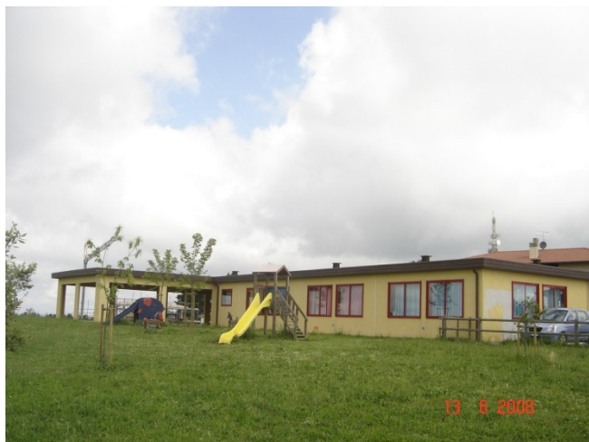
Foto 03 – vista della scuola
