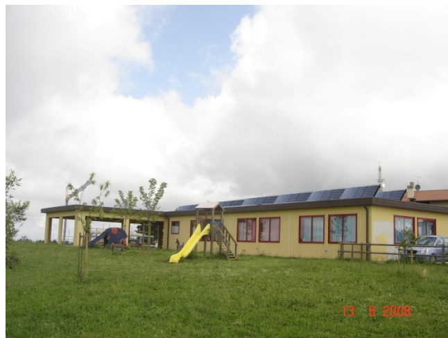
Foto 04 – vista della scuola con i pannelli fotovoltaici
