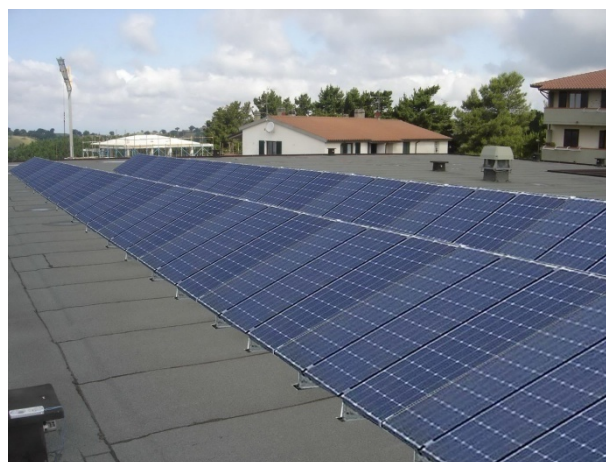
Foto 02 – vista della superficie della scuola con l'installazione dei pannelli fotovoltaici
