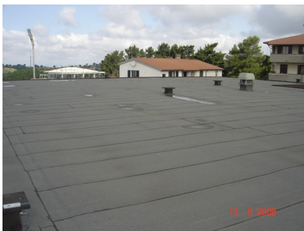
Foto 01 – vista della superficie di copertura della scuola
