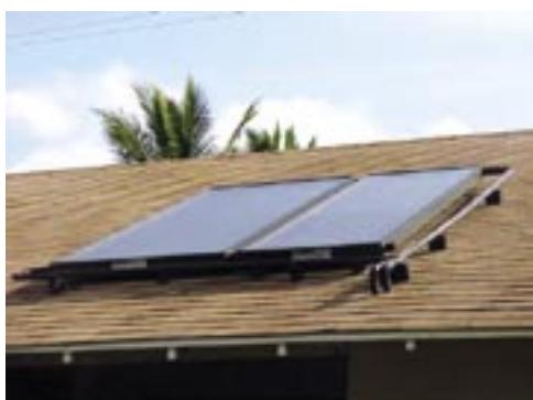
i muri esterni (installazione verticale) o i tetti a falde e con tegole. Le dimensioni orientative per la scelta di un sistema compatto sono di circa 0,7-0,8 m<sup>2</sup> per persona, sufficienti per fornire 50-60 litri d'acqua calda giornaliera a 45 °C. Nell'arco dell'anno si può risparmiare dal 50 al 70% dell'energia necessaria alla produzione dell'acqua calda sanitaria.
