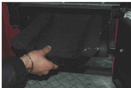
Pulizia camera di combustione con refrattario estraibile
