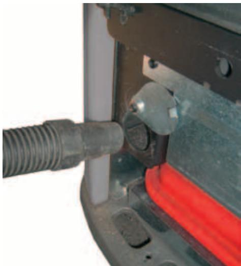
Aspirer les conduits avec un aspirateur adapté ou, si possible, avec notre BIDON ASPIRE-CENDRES
