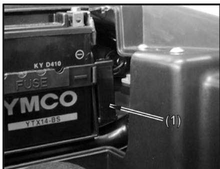
(1) Vano porta fusibili 10-15 A
