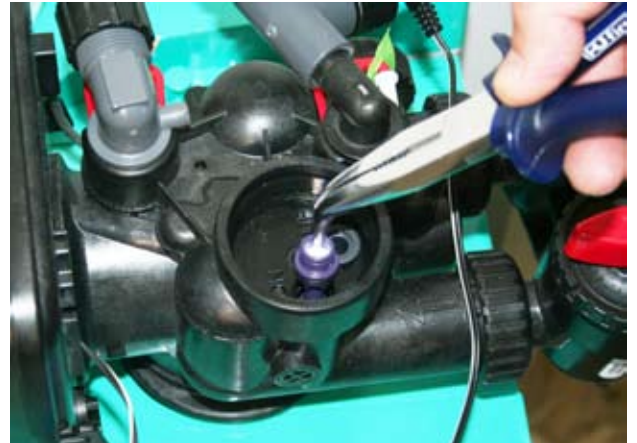
2 - Sfilare l'eiettore con l'aiuto di una pinza
