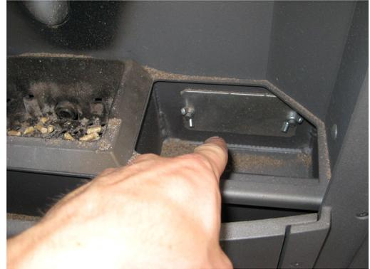
**APRIRE LE DUE ISPEZIONI A DX E A SX DEL BRUCIATORE PER ASPIRARE IL DEPOSITO TOLTO DALLA SCHIENA DELL'INSERTO.**
