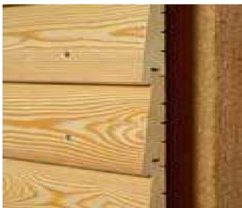
In corrispondenza delle pareti Est ed Ovest è prevista la realizzazione di un rivestimento in doghe di legno di larice non trattato fissato alla muratura retrostante con listelli anch'essi in larice.
