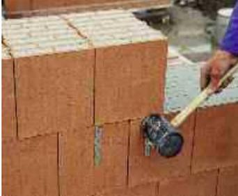
Le pareti esterne di tamponamento sono realizzate con blocchi rettificati riempiti con perlite delle dimensioni di 49x24,8x24,9 cm e 30x24,8x24,9 cm.
