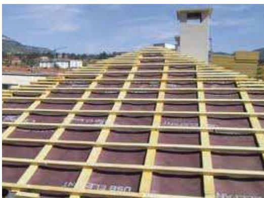
Su tale strato isolante sarà posto un manto impermeabile all'acqua USB (PP. PP. PP.) del tipo elefant od equivalente che sarà posto con le medesime modalità di esecuzione del freno vapore.
