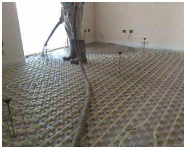
Dal terzo giorno aerare l'ambiente per favorire sia l'indurimento sia per ottenere una essiccazione ottimale del massetto.
