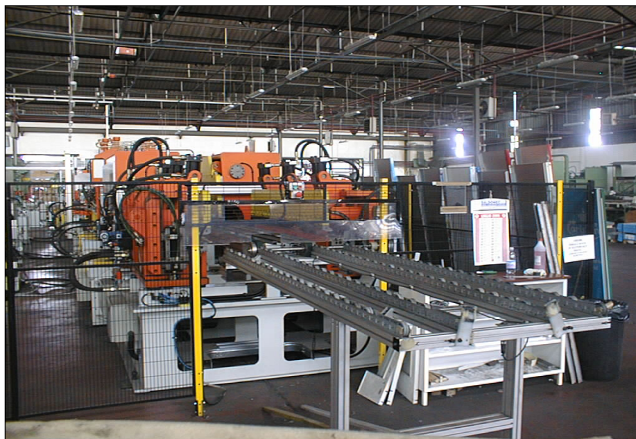
Foto 2 – veduta prospettica della linea di lavorazione automatica lamiera CIMSA.
