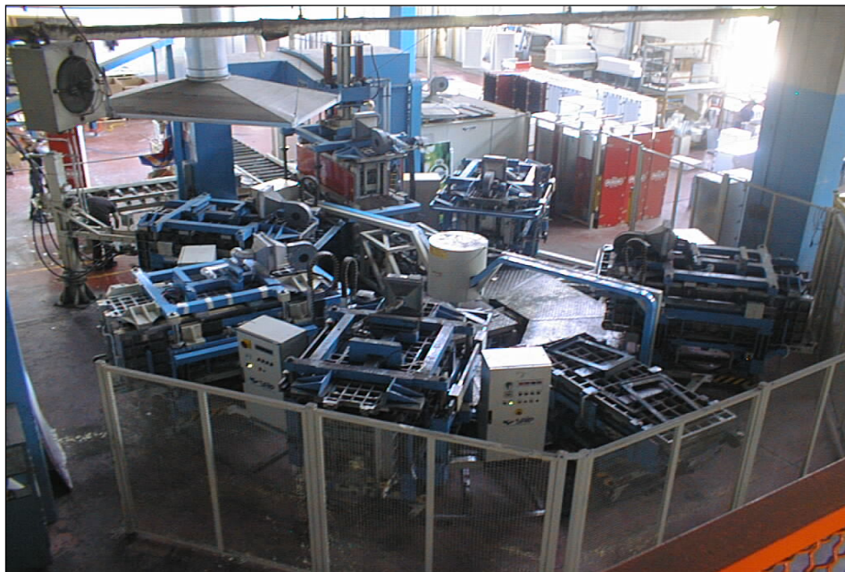
Foto 5 – veduta dall’alto dell’impianto di schiumatura delle scocche (iniezione miscela isocianato e poliolo), è visibile la cappa di aspirazione dei vapori posizionata sopra la testa di iniezione.
