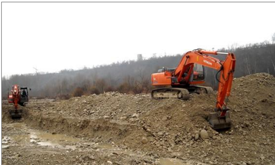
Figura 41: operazioni di scavo
