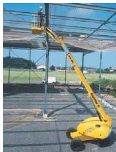
Le Piattaforme idrauliche semoventi, sono utilizzate per il sollevamento del personale addetto a lavorazioni “in quota”.
