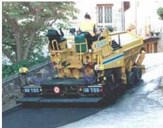
La Vibrofinitrice, chiamata anche Finitrice o “spandigraniglia”, è la macchina maggiormente utilizzata nel campo delle pavimentatrici stradali, al fine di stendere il manto di asfalto sulla pavimentazione.
