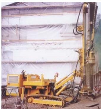
La Perforatrice idraulica è la macchina più indicata per l'esecuzione di micropali, sondaggi o la realizzazione di tiranti all'interno di aree di lavoro anche di medio – piccole dimensioni.
