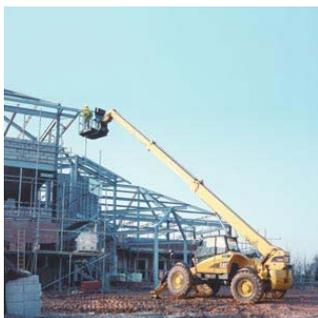
Progettate per il sollevamento e il trasporto di materiale, questo tipo di macchine possono anche essere utilizzate come sollevatori di personale addetto a lavori "in quota" (come saldature, rifiniture o tinteggiature), comportandosi in maniera simile ad una piattaforma idraulica.
