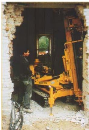
Grazie a speciali allestimenti che consentono di adottare accessori che rispondono a specifiche richieste di perforazione (jet grouting, pompa fango o pompa schiuma), la perforatrice idraulica consente di poter godere di un campo di applicazione molto vasto, che spazia:
