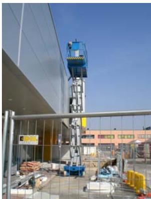
Le Piattaforme motorizzate a sollevamento verticale, chiamate anche Scissor, sono largamente utilizzate per il sollevamento di personale addetto alla lavorazione a quote elevate.
