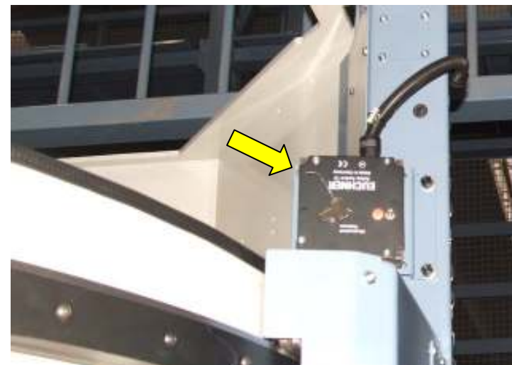
Chiavistelli su porte posto operatore per carico-scarico
