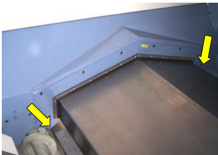
Pulizia canali laterali basamento
