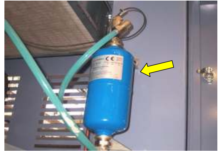
Controllo accumulatore raffreddamento mandrino
