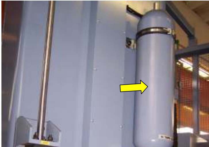
Verifica precarica accumulatore 24,5 lt. impianto idraulico bilanciamento carrello multipallet
