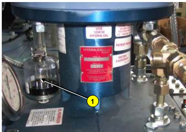
Sostituzione olio pompa alta pressione refrigerante
