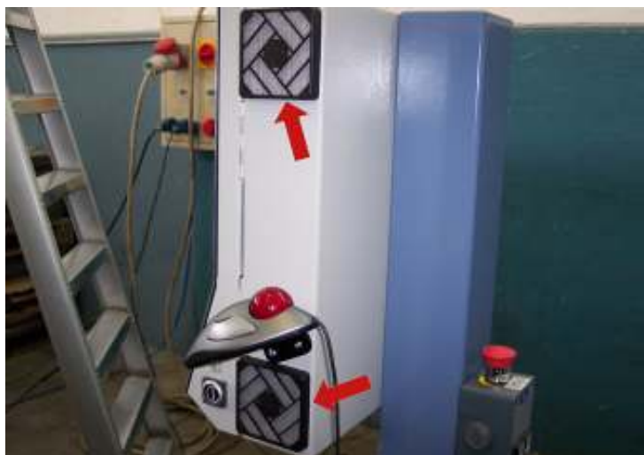
Pulizia filtri ventilatore pannello J-TERM1 su magazzino utensili
