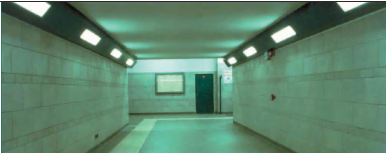
Sottopassaggio con illuminazione laterale.
