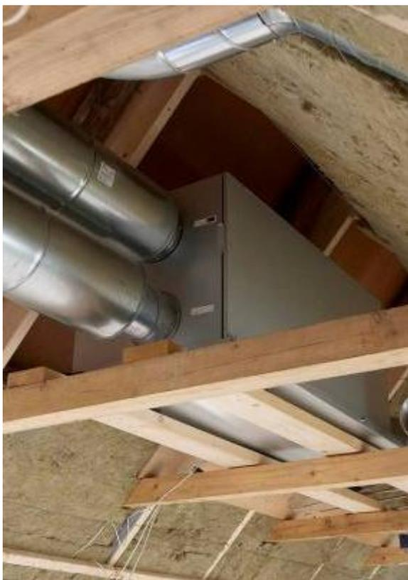
Le unità di ventilazione HCH sono apparecchiature per applicazioni domestiche di tipo orizzontale, progettate per essere installate nel sottotetto, controsoffitto o in un locale tecnico.
