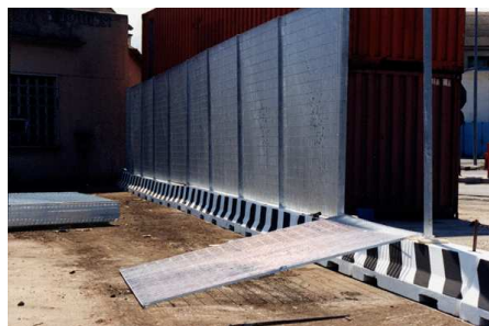
fig. 4.2 – Barriere di cls con soprastanti rete di recinzione e lampade di sicurezza rosse
