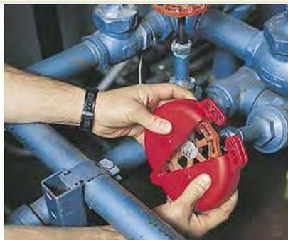
Racchiude l'intera valvola, quindi non può più essere aperto o chiuso. Il coperchio della valvola V-SAFE è costituito da due mezzelune appiattite che ricoprono completamente la valvola. Costruito in polipropilene dielettrico, estremamente resistente a graffi e abrasioni, Resistente agli sbalzi di temperatura.
