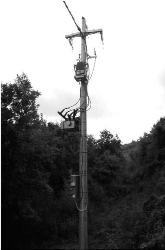
Sezionatore FLUSARC PEØ con comando motorizzato e trasformatore
