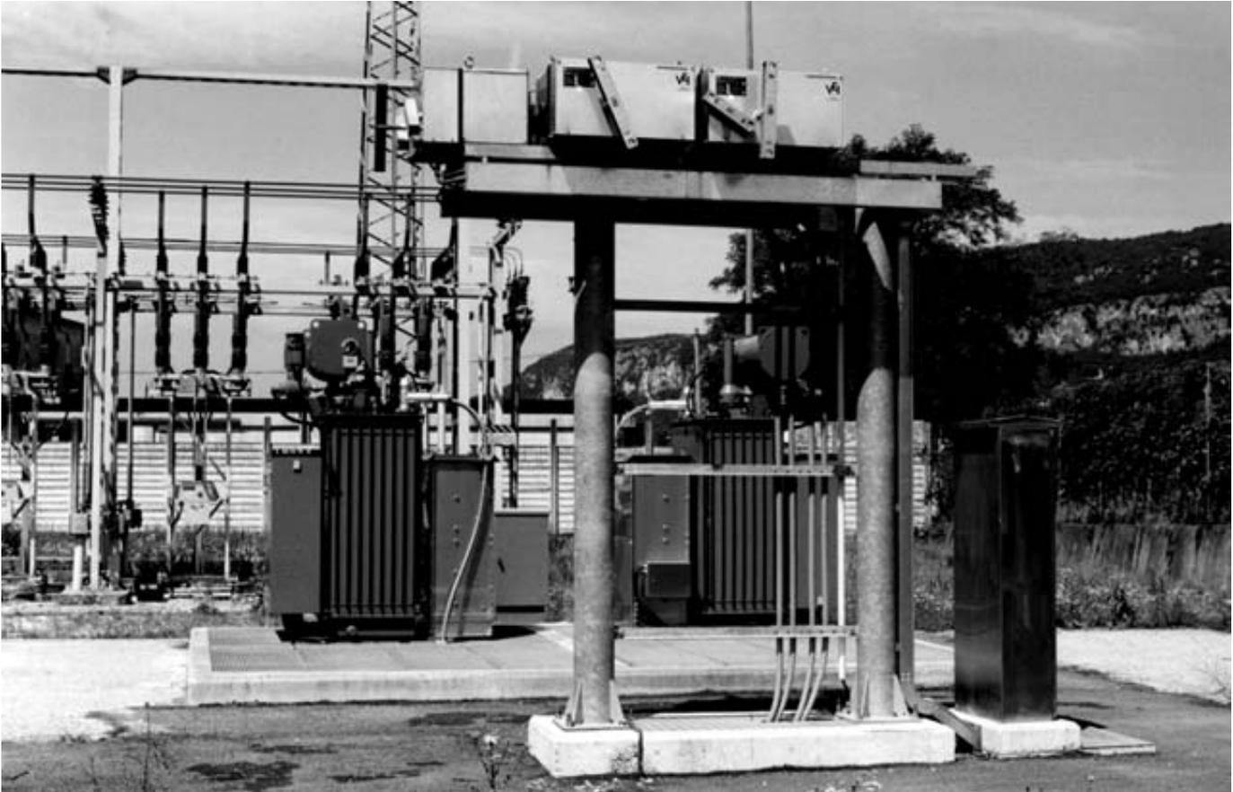
Esempio d'installazione di interruttore di manovra sezionatore FLUSARC PE-U per comando bobina di Petersen (Garda - Italia)
