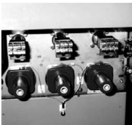
Box prova cavi laterale del FLUSARC FA
