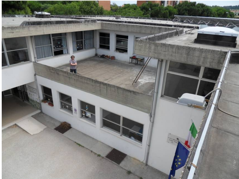
Figura 3 - Ingresso al plesso e terrazza per salita al piano coperture
