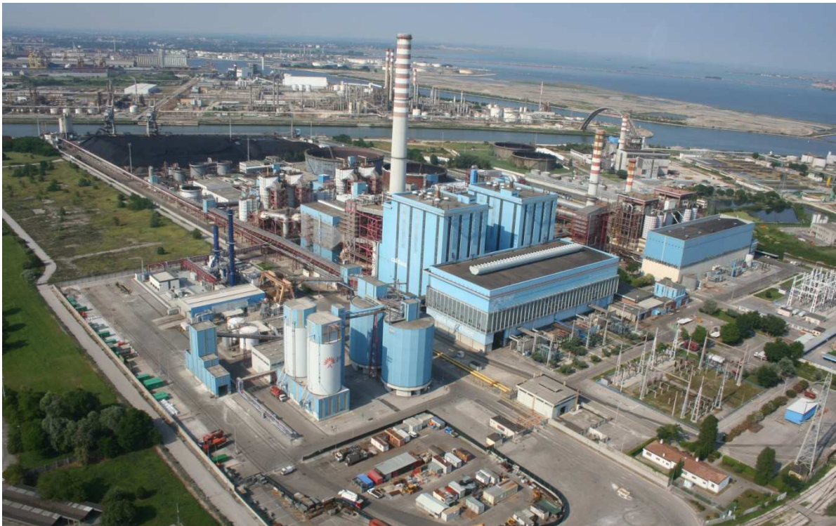
Figura 1.1 : Vista aerea dell'impianto termoelettrico di Fusina
