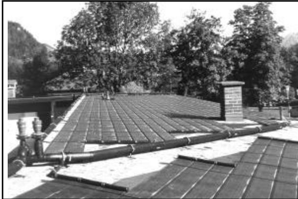
**Impianto per riscaldamento di una piscina pubblica**Esempio per una piscina di 1 000 m<sup>2</sup> di superficie:Area dei collettori: 300 m<sup>2</sup>
