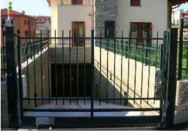
Il cancello carrale, a chiusura dei box di ogni singola palazzina, sarà anch'esso prefabbricato in ferro zincato e preverniciato e sarà del tipo a battente e/o scorrevole motorizzato (come da progetto); sarà fornito un telecomando per ogni alloggio.
