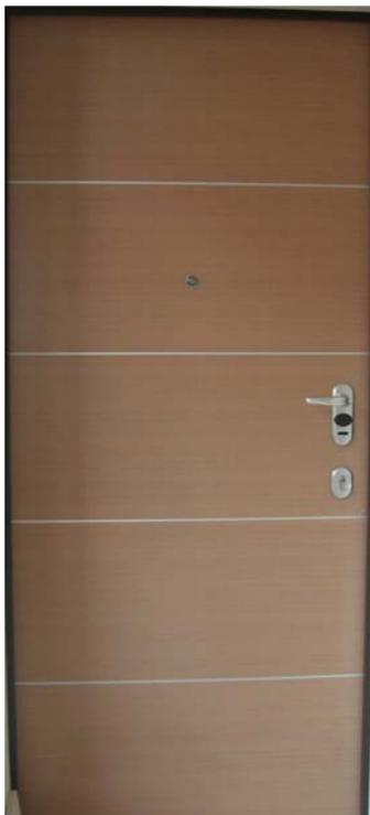
Tutte le unità abitative saranno dotate di portoncini blindati della ditta DIERRE modello NUOVA AT 3, configurazione con isolamento termico interno, dimensioni cm. 90x210.
