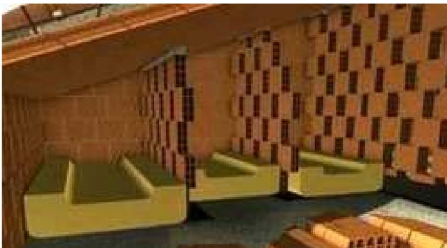
Solaio inclinato di copertura
