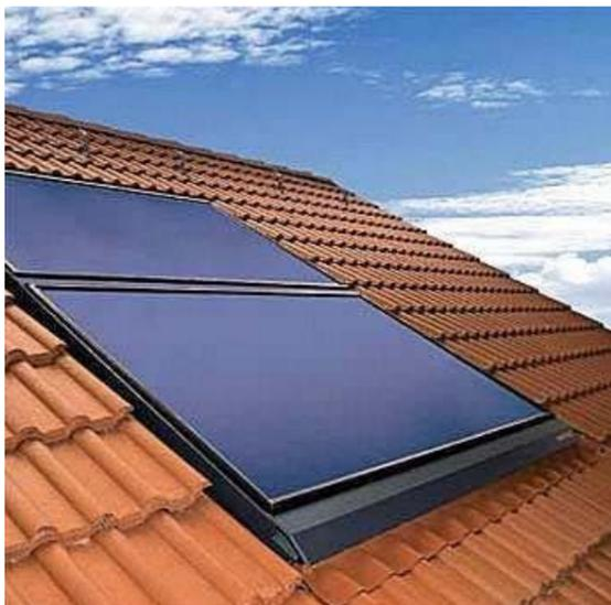
Ad integrazione dell'impianto per la produzione di acqua calda sanitaria è prevista la realizzazione di pannelli solari termici che supportando la caldaia garantiranno un notevole risparmio in termini di consumi energetici. L'impianto è dimensionato per coprire il 50% dell'energia primaria necessaria per la produzione dell'acqua calda ad utilizzo sanitario. I pannelli verranno installati sulla copertura degli edifici e corredati delle apposite lattonomie.
