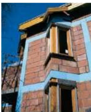
La struttura in calcestruzzo armato gettata in opera, garanzia per la statica degli edifici, se non adeguatamente isolata dal punto di vista termico, è il nemico numero uno per la formazione delle muffe.
