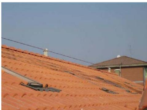
Uno sguardo attento alla sicurezza ci ha portato ad installare sulla copertura delle nostre case un dispositivo di sicurezza denominato "linea vita" che consente l'accesso alla copertura in sicurezza garantendo punti di ancoraggio necessari per eseguire le manutenzioni in totale sicurezza.
