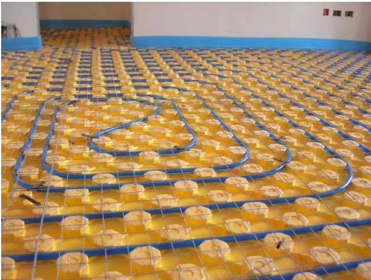
Il riscaldamento degli ambienti è garantito da pannelli radianti a pavimento che emanano calore attraverso tutta la superficie del pavimento, facendo in modo che la differenza di temperatura tra questo e l'ambiente risulti modesta e tale da non creare disagio camminando sul pavimento ed evitando di innescare movimenti dell'aria all'interno degli ambienti.
