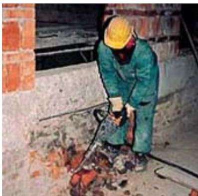
Operazioni di demolizione di strutture collegate ai corpi di fabbrica da non demolire eseguita con mezzi meccanici o a mano dove occorra.
