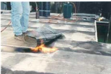
La fase di lavoro consiste nello stendere i teli d'impermeabilizzazione su copertura piana o inclinata per la saldatura, a mezzo fiamma, al sottofondo predisposto con mano di bitume a freddo. In particolare si prevede:
