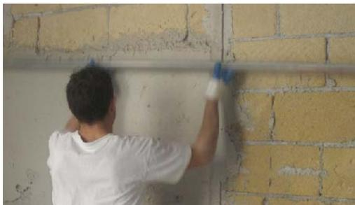
Realizzazione di intonaci esterni su superfici verticali e/o orizzontali eseguiti a mano. L'applicazione manuale dell'intonaco esterno richiede le seguenti accortezze ai fini di buoni risultati:
