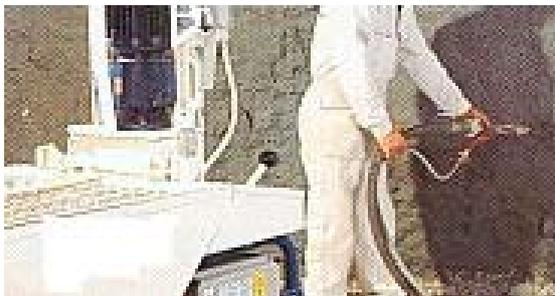
Trattasi dell'applicazione di intonaci interni su superfici verticali e/o orizzontali mediante l'utilizzo di macchina intonacatrice. L'intonaco civile interno viene applicato come elemento protettivo e decorativo delle superfici murarie interne, in quanto l'umidità, la condensa e la presenza di microrganismi nelle superfici murarie rendono necessaria la loro protezione e manutenzione.
