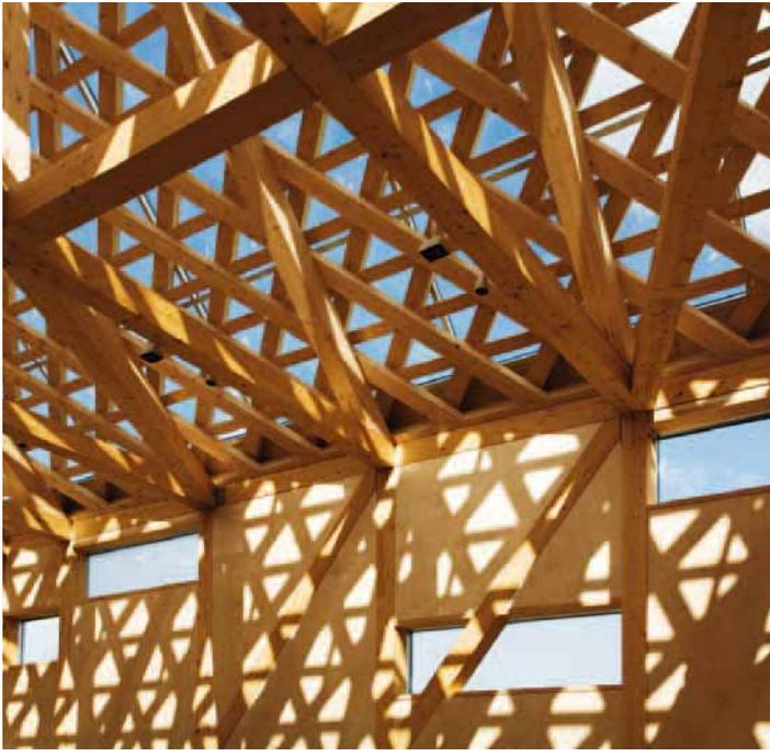
Il sistema strutturale è costituito da sezioni quadrate di abete lamellare, contenute nello spessore delle pareti ma lasciate a vista: i pilastri "disegnano" le superfici e si manifestano nelle loro caratteristiche materiche diverse dai pannelli di tamponamento.
