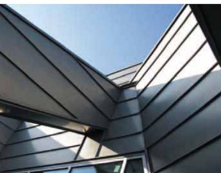
Il laminato Zintek®, prodotto da Simar Spa e commercializzato da Zintek Srl è tecnicamente una lega composta di zinco, rame e titanio, con una percentuale di zinco pari al 99,995 per cento. È incombustibile, immune all'erosione del vento e resistente ai raggi ultravioletti; inoltre al contatto con l'ossigeno si ricopre di uno strato protettivo stabile nel tempo, che ne garantisce una lunghissima durata. La sua applicazione ideale prevede l'abbinamento ad un pacchetto
