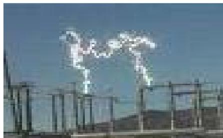
E' costituito da una sorgente di calore assai intensa e concentrata, con emissione di gas e di vapori surriscaldati e tossici, irraggiamento termico e raggi ultravioletti che si manifestano in caso di guasto o di manovre su apparecchiature elettriche, es. corto circuiti.
