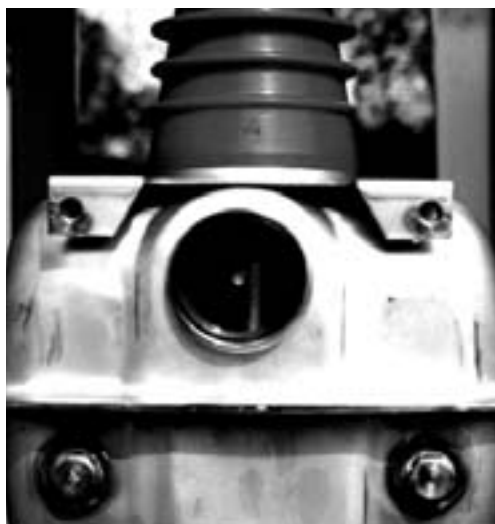
Oblo' di ispezione dei contatti Contact inspection window
