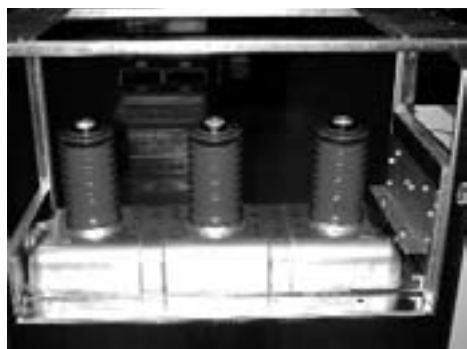
Isolatori superiori dell'interruttore FLUVAC Upper isolators of FLUVAC circuit breaker
