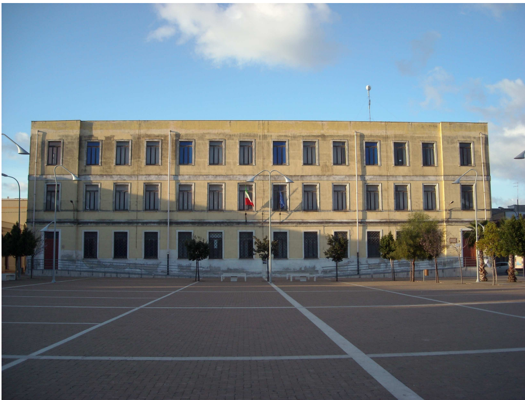
Foto n. 1 – Lato Sud- Piazza Matteotti
