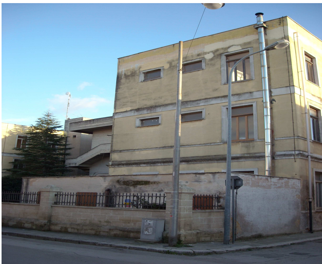
Foto n. 3 – Lato Nord - Via XXIV Maggio
