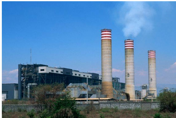
Fig. 2.3: Esempio di centrale termoelettrica.
