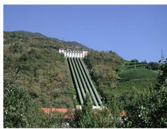
Fig. 2.2: Esempio di condotte forzate.
