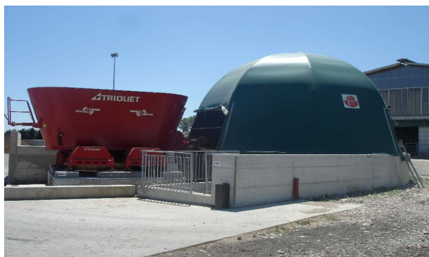
Tramoggia di carico e vasca di omogeneizzazione abbinata a pompa trituratrice
