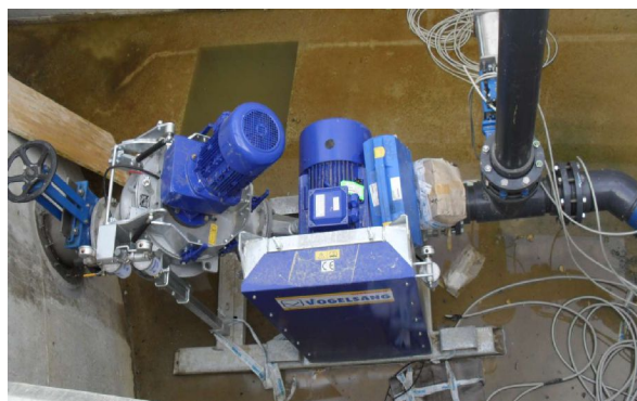
Tramoggia di carico e vasca di omogeneizzazione abbinata a pompa trituratrice
