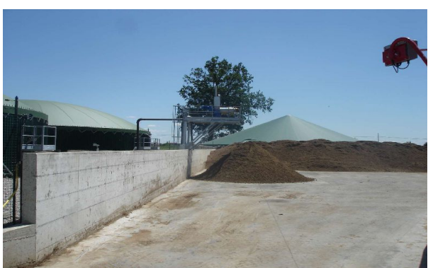
Digestori anaerobici e collettore distribuzione, cogeneratore e platea di stoccaggio del solido separato con vasca di stoccaggio finale coperta
